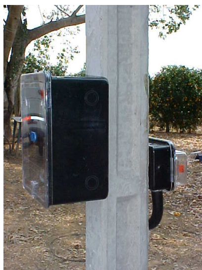
Padrão compacto com caixa de medição em policarbonato para 1 cliente residencial, obrigatoriamente voltado para a calçada
