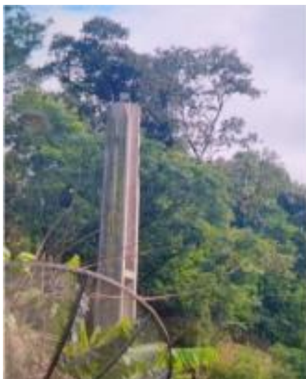
Figura 25- Evidência de Campo Norte, Município de Mariano Moro - Fonte: RGE
