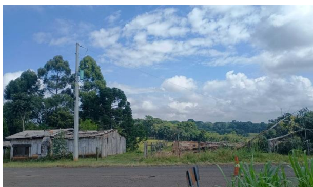
Figura 65 - Evidência de Campo Serra, Município de Pinhal da Serra - Fonte: RGE
