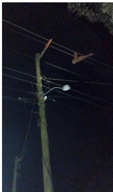
Figura 60 - Evidência de Campo Vale do Taquari, Município de São Sebastião do Caí - Fonte: RGE
