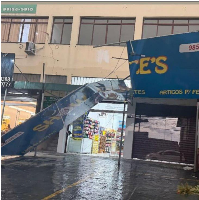
Figura 34– Evidência de Campo Canoas, Município de Canoas - Fonte: RGE
