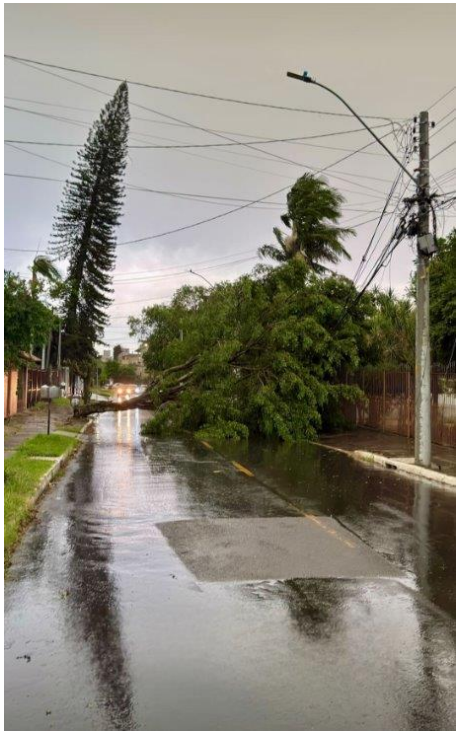
Figura 37- Evidência de Campo Canoas, Município de Canoas- Fonte: RGE
