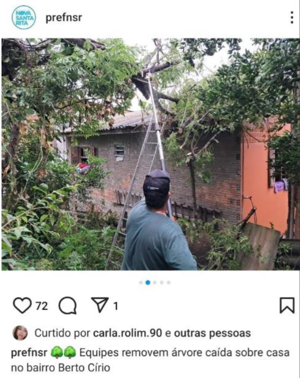
Figura 47- Evidência de Campo Vale do Taquari, Município de Nova Santa Rita - Fonte: Prefeitura Nova Santa Rita
