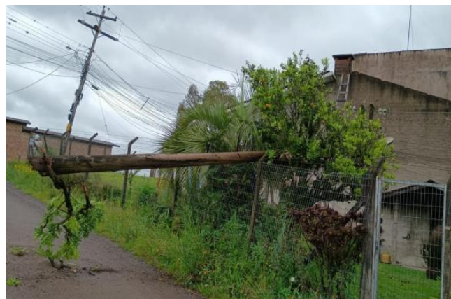
Figura 55 - Evidência de Campo da Região da Serra, Estação Avançada de Caxias do Sul - Fonte: RGE
