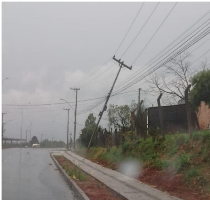
Figura 109 - Evidência de Campo da Região Canoas, Estação Avançada de Gravataí- Fonte: RGE
