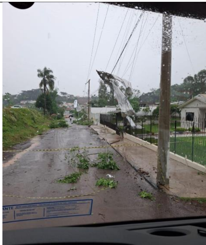
Figura 106 - Evidência de Campo da Região Planalto, Estação Avançada de Erechim- Fonte: RGE
