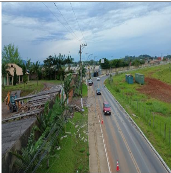
Figura 118 - Evidência de Campo da Região Canoas, Estação Avançada de Gravataí- Fonte: RGE
