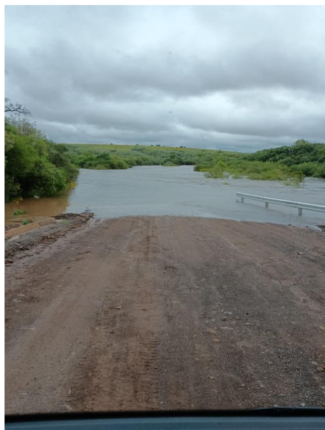
Figura 79 - Evidência de Campo da Região Pampas, Estação Avançada de Santana do Livramento - Fonte: RGE
