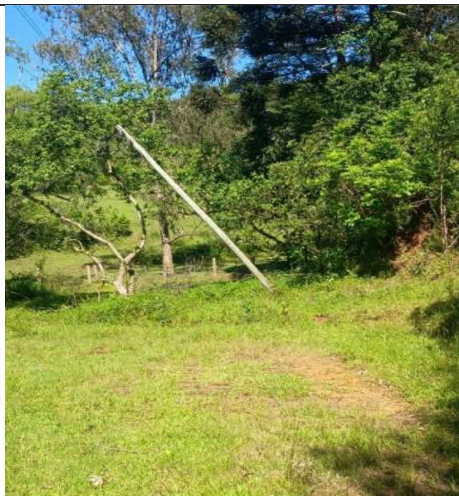
Figura 119 - Evidência de Campo da Região Canoas, Estação Avançada de Gravataí- Fonte: RGE
