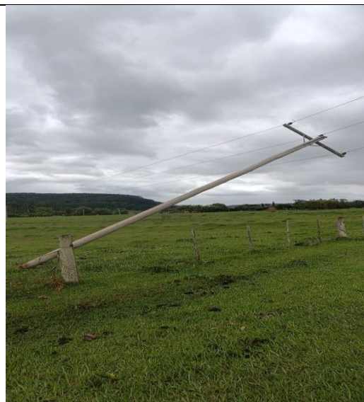
Figura 183 - Evidência de Campo da Região Serra, Estação Avançada de Gramado- Fonte: RGE
