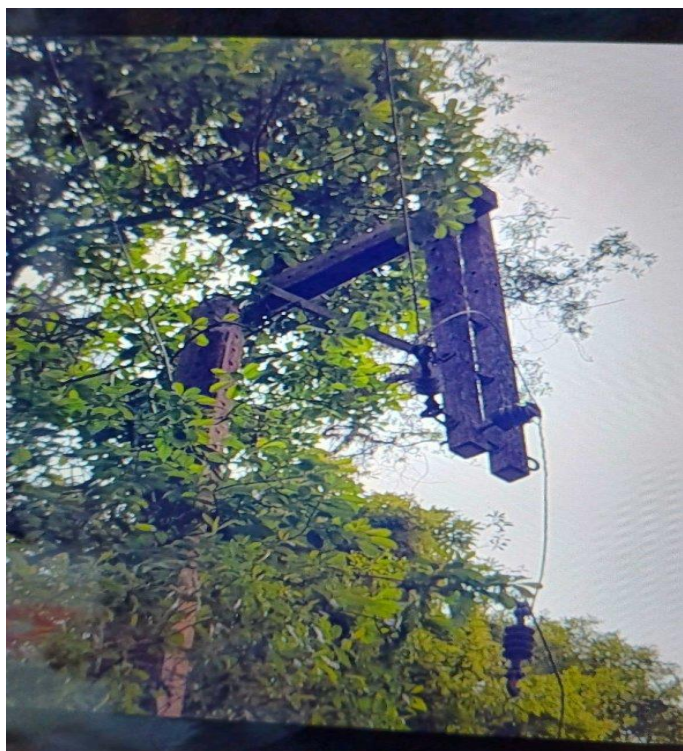
Figura 152 - Evidência de Campo da Região Serra, Estação Avançada de São Marcos- Fonte: RGE
