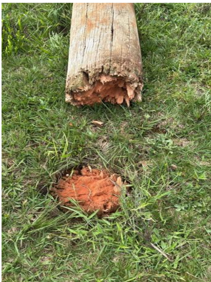
Figura 104 - Evidência de Campo da Região Planalto, Estação Avançada de Lagoa Vermelha- Fonte: RGE
