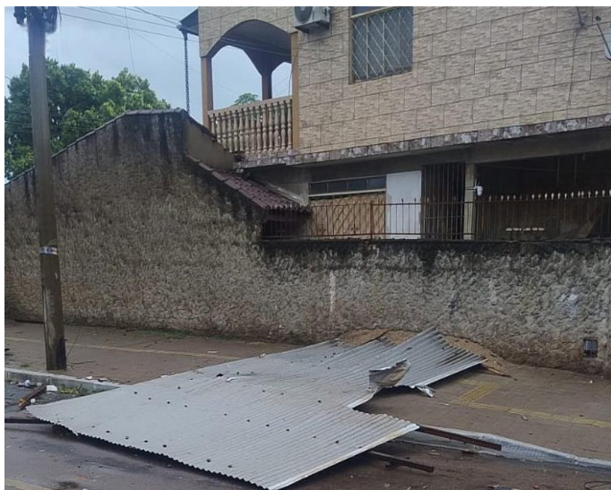
Figura 34 - Evidência de Campo da Região de Canoas, Município Canoas - Fonte: RGE
