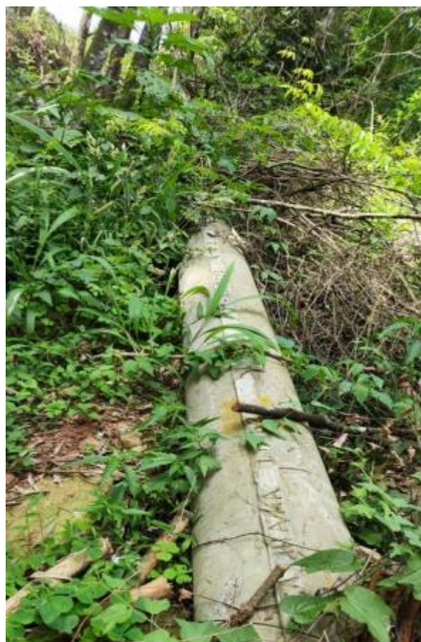
Figura 57 - Evidência de Campo da Região da Serra, Estação Avançada de Caxias do Sul - Fonte: RGE
