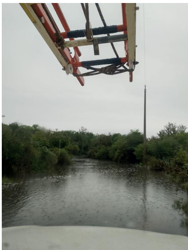
Figura 76 - Evidência de Campo da Região Pampas, Estação Avançada de Santana do Livramento - Fonte: RGE
