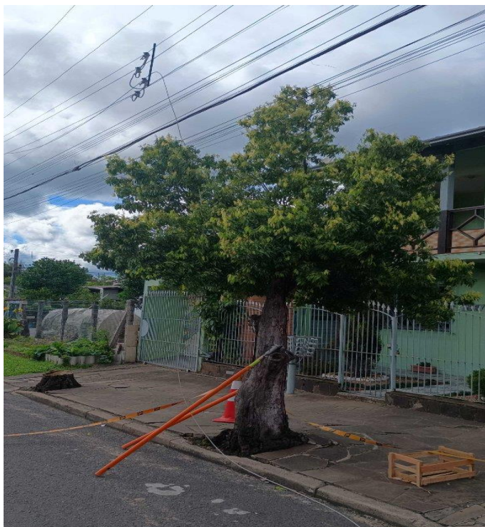
Figura 130 - Evidência de Campo da Região Canoas, Estação Avançada de Sapucaia do Sul- Fonte: RGE
