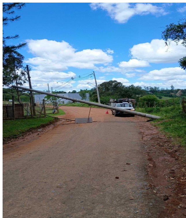
Figura 173 - Evidência de Campo da Região Canoas, Estação Avançada de Gravataí - Fonte: RGE
