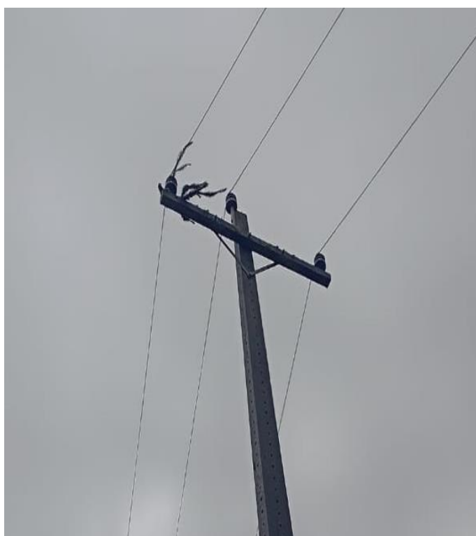
Figura 100 - Evidência de Campo da Região Planalto, Estação Avançada de Lagoa Vermelha- Fonte: RGE
