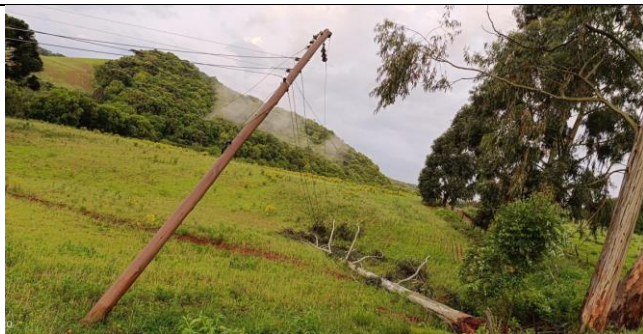
Figura 102 - Evidência de Campo da Região Planalto, Estação Avançada de Lagoa Vermelha- Fonte: RGE
