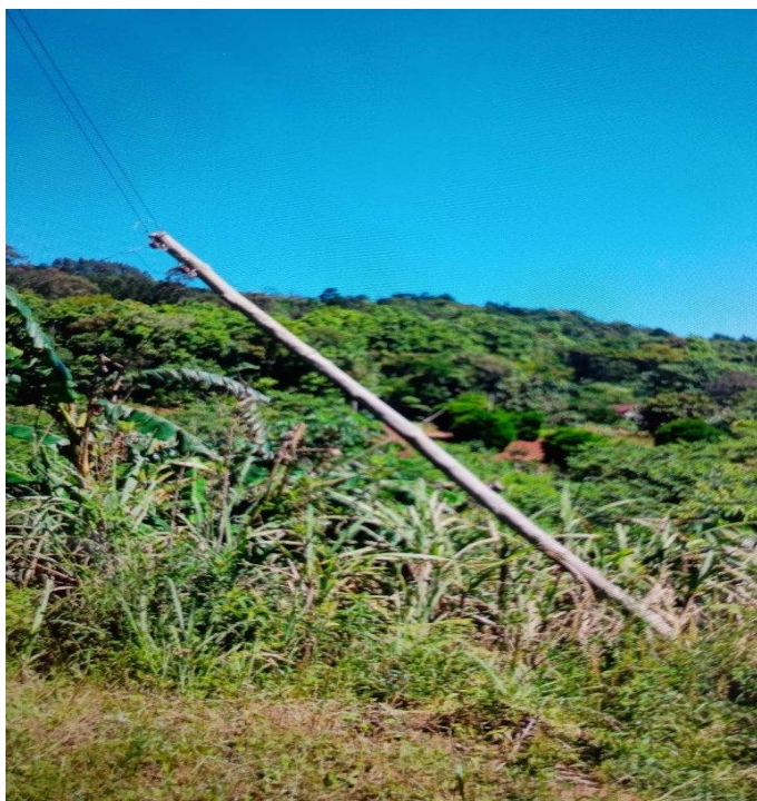
Figura 160 - Evidência de Campo da Região Vale dos Sinos, Estação Avançada de Rolante - Fonte: RGE
