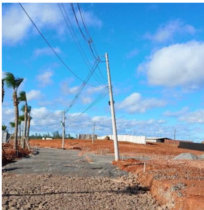
Figura 120 - Evidência de Campo da Região Canoas, Estação Avançada de Gravataí- Fonte: RGE
