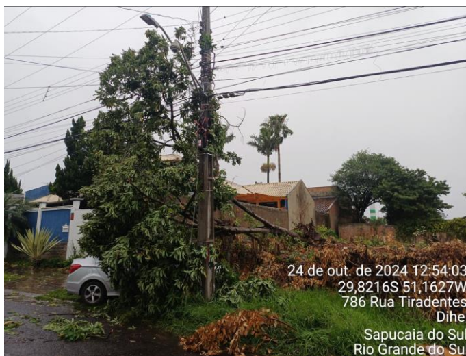
Figura 180- Evidência de Campo da Região da Canoas, Estação Avançada de Sapucaia do Sul - Fonte: RGE
