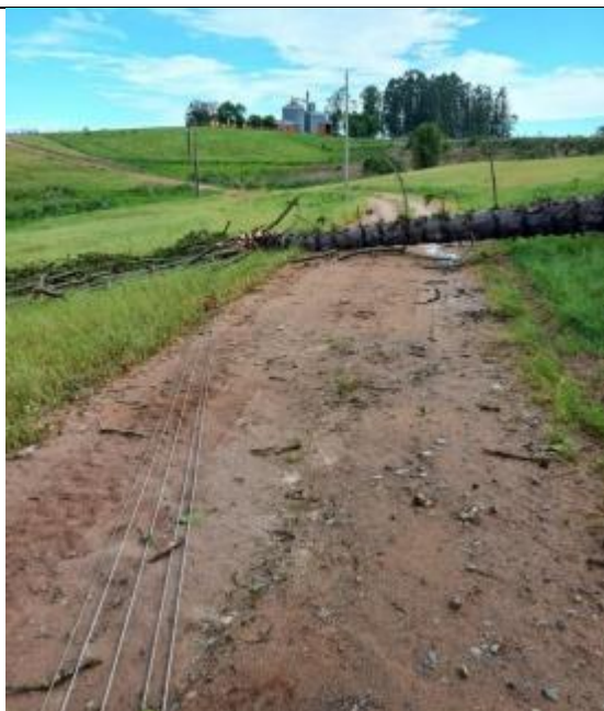
Figura 70 - Evidência de Campo da Região Central, Estação Avançada de Caçapava do Sul - Fonte: RGE
