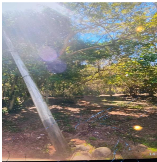
Figura 125 - Evidência de Campo da Região Canoas, Estação Avançada de Sapucaia do Sul- Fonte: RGE
