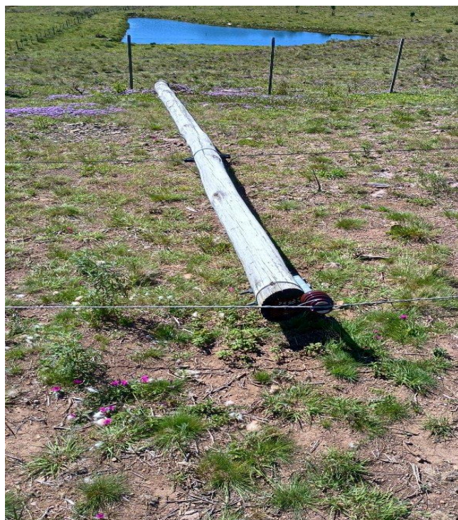
Figura 153 - Evidência de Campo da Região Serra, Estação Avançada de Cambara- Fonte: RGE
