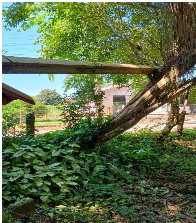
Figura 150 - Evidência de Campo da Região Vale do Taquaris, Estação Avançada de Lajeado Fonte: RGE
