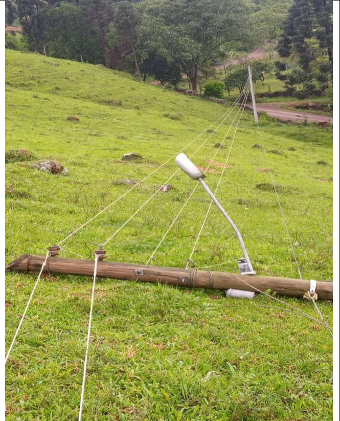
Figura 189 - Evidência de Campo da Região Serra, Estação Avançada de Gramado- Fonte: RGE
