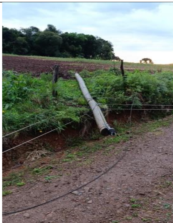
Figura 99 - Evidência de Campo da Região Planalto, Estação Avançada de Lagoa Vermelha- Fonte: RGE
