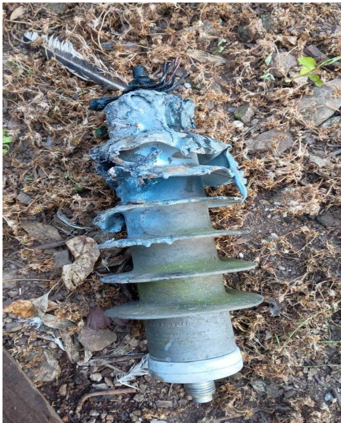
Figura 134 - Evidência de Campo da Região Planalto- Estação Avançada de Veranópolis - Fonte: RGE
