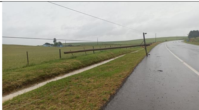
Figura 103 - Evidência de Campo da Região Planalto, Estação Avançada de Lagoa Vermelha- Fonte: RGE
