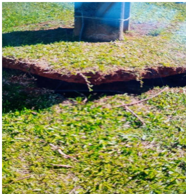
Figura 165 - Evidência de Campo da Região Serra, Estação Avançada de Esmeralda - Fonte: RGE
