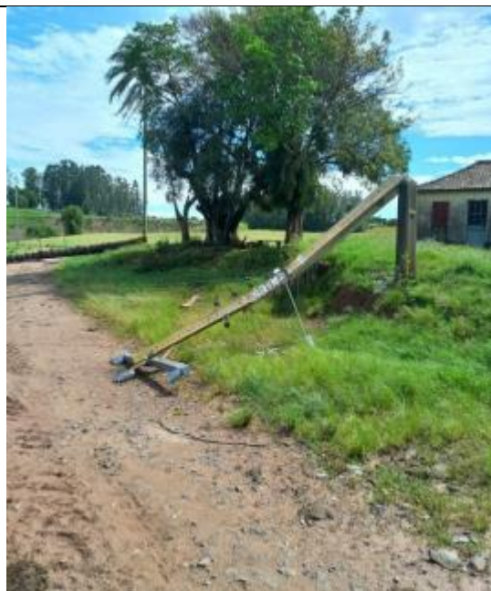
Figura 71 - Evidência de Campo da Região Central, Estação Avançada de Caçapava do Sul - Fonte: RGE
