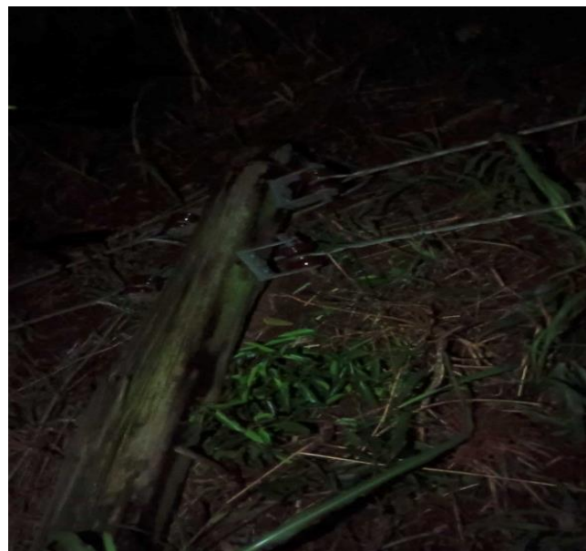
Figura 185 - Evidência de Campo da Região Serra, Estação Avançada de Gramado- Fonte: RGE
