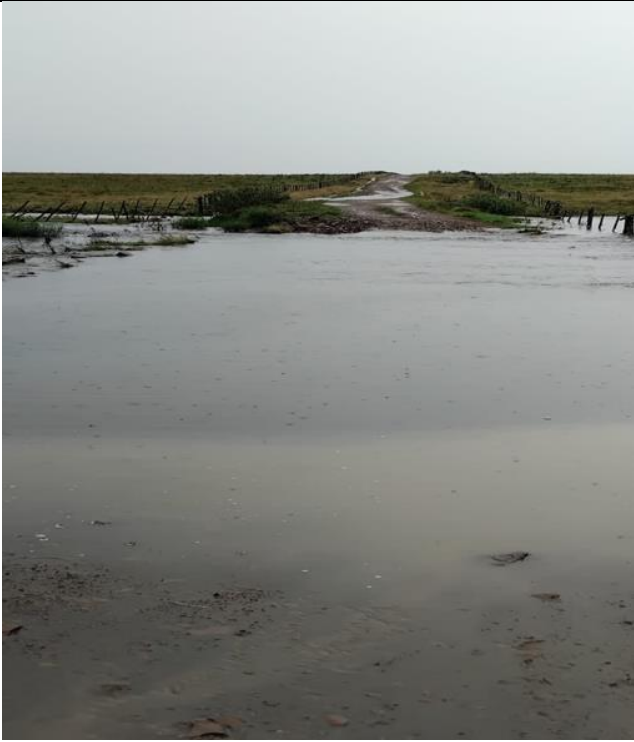
Figura 44 - Evidência de Campo do Pampas, Santana do Livramento - Fonte: RGE
