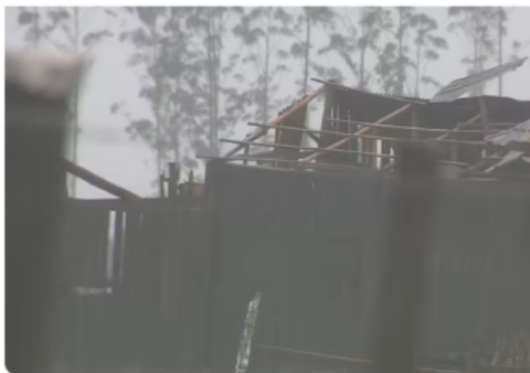
Casa destelhada em Camaquã, no RS — Foto: Reprodução/ RBS TV
