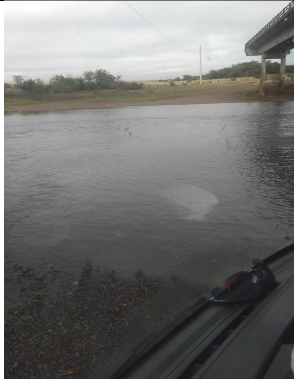
Figura 45 - Evidência de Campo do Pampas, Santana do Livramento - Fonte: RGE
