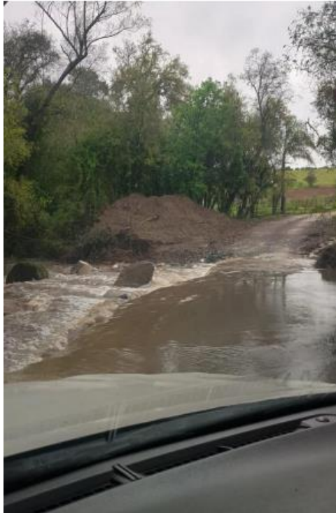
Figura 28 - Evidência de Campo Central, Caçapava do Sul - Fonte: RGE
