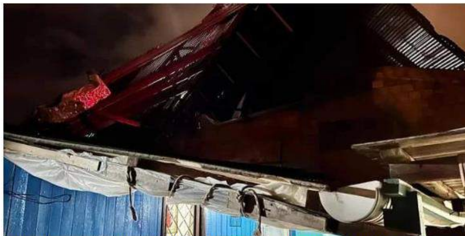
Em Uruguaiana, ao menos 20 moradias solicitaram lonas a Defesa CIVIL depois do destelhamento total ou parcial | Foto: Defesa CIVIL / Divulgação / CP
