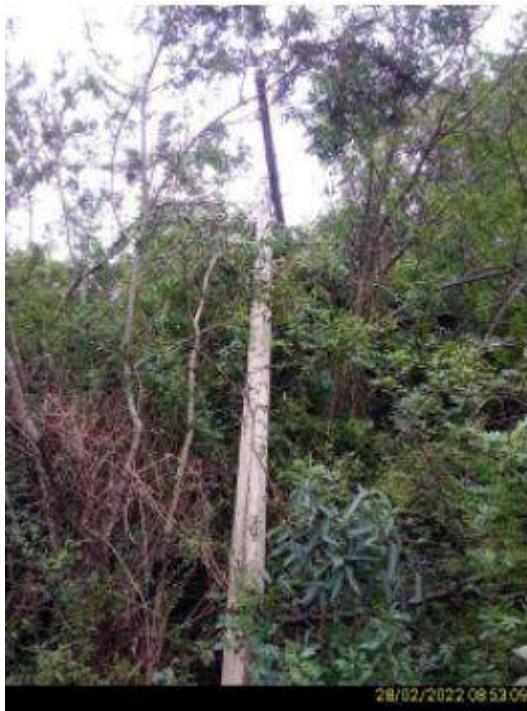
Figura 23-Evidência de Campo. Fonte : RGE
