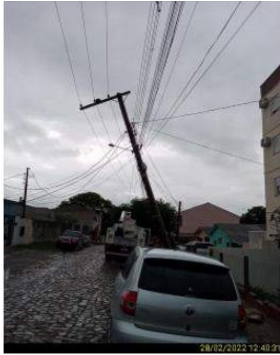
Figura 21-Evidência de Campo. Fonte : RGE
