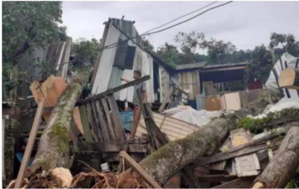
Casa totalmente destruída na Rua Pastor Jairo Ferreira dos Santos, no Kephass
