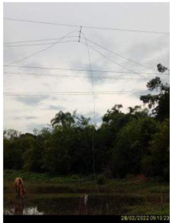
Figura 24-Evidência de Campo. Fonte : RGE
