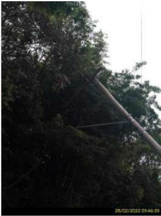
Figura 29-Evidência de Campo. Fonte : RGE
