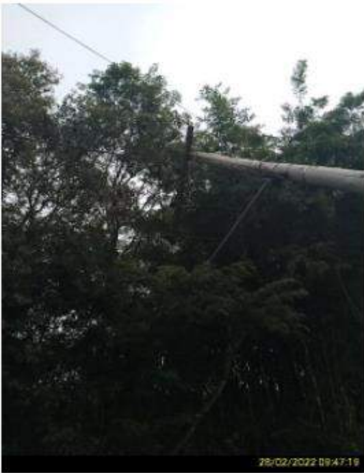
Figura 27-Evidência de Campo. Fonte : RGE
