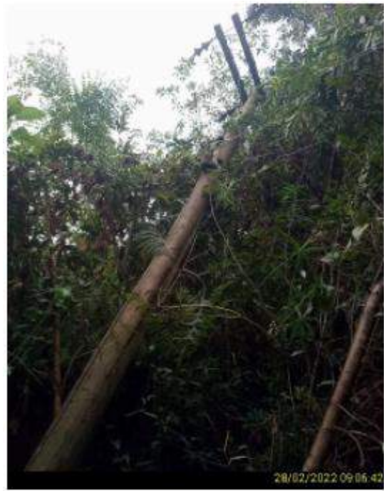
Figura 26-Evidência de Campo. Fonte : RGE
