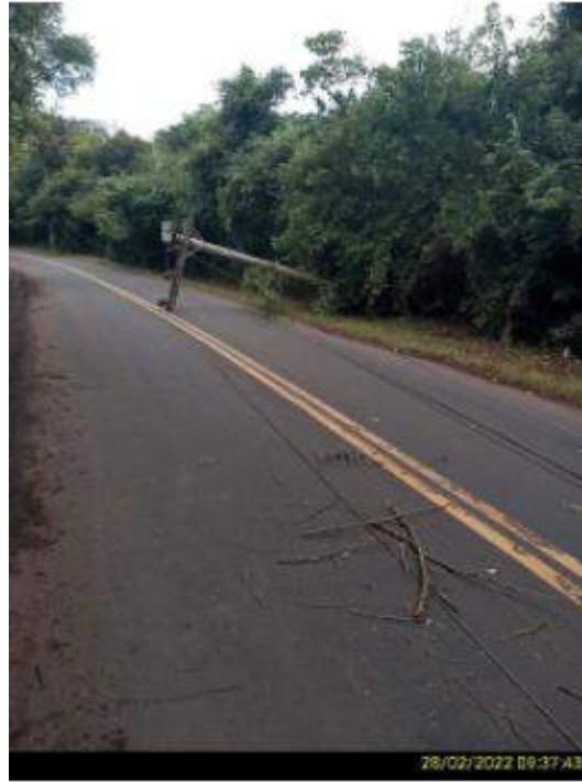
Figura 30-Evidência de Campo. Fonte : RGE
