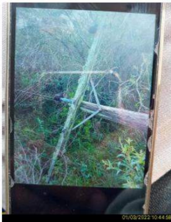
Figura 20-Evidência de Campo. Fonte : RGE
