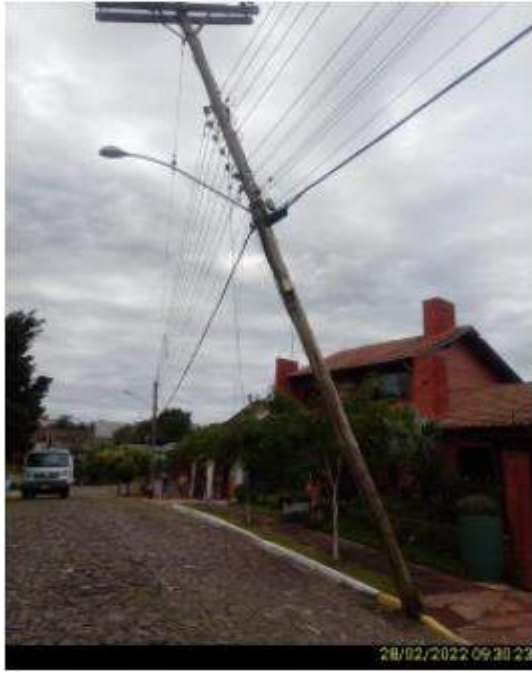
Figura 33-Evidência de Campo. Fonte : RGE
