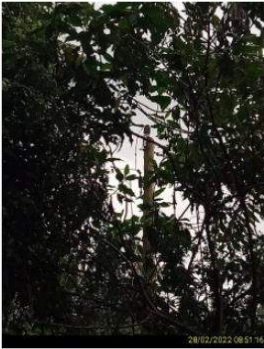
Figura 25-Evidência de Campo. Fonte : RGE
