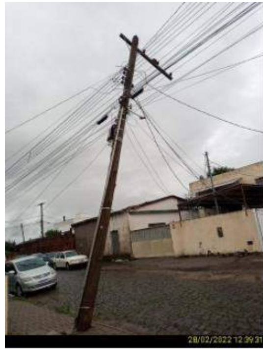
Figura 22-Evidência de Campo. Fonte : RGE
