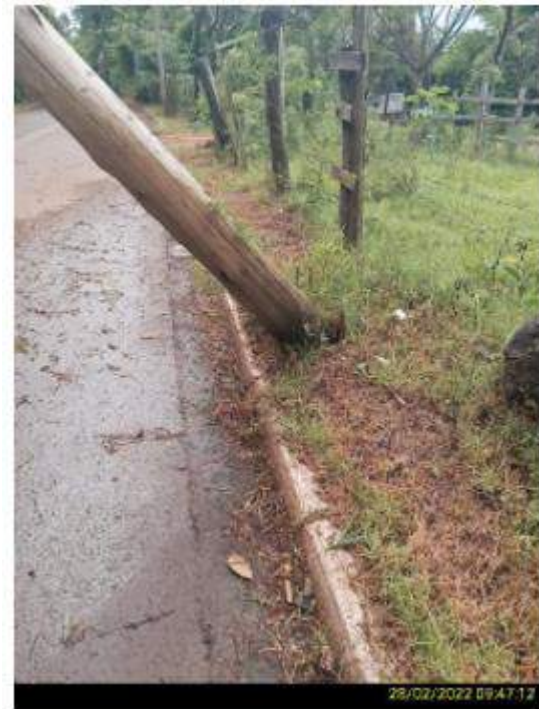
Figura 28-Evidência de Campo. Fonte : RGE
