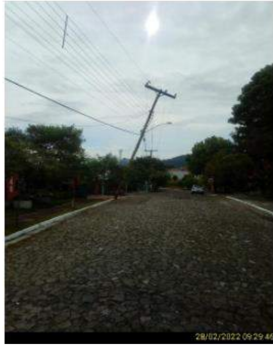
Figura 34-Evidência de Campo. Fonte : RGE
