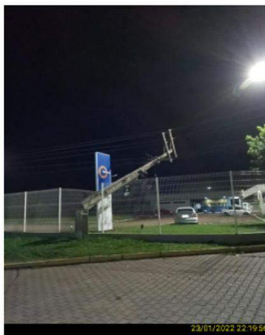
Figura 25 - Evidência de Campo. Fonte : RGE
