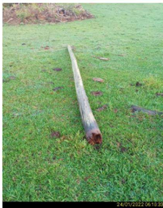
Figura 24 - Evidência de Campo. Fonte : RGE
