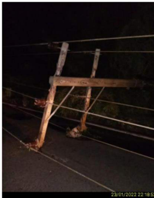
Figura 21 - Evidência de Campo. Fonte : RGE
