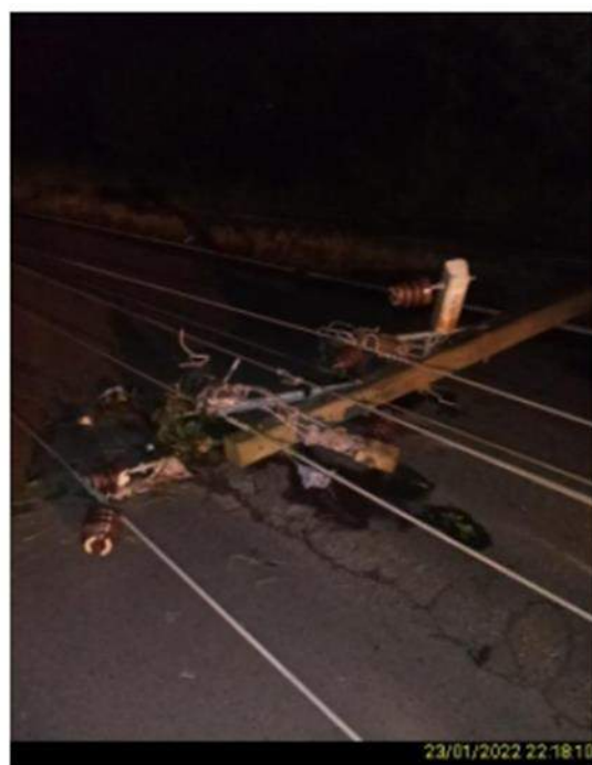
Figura 20 - Evidência de Campo. Fonte : RGE
