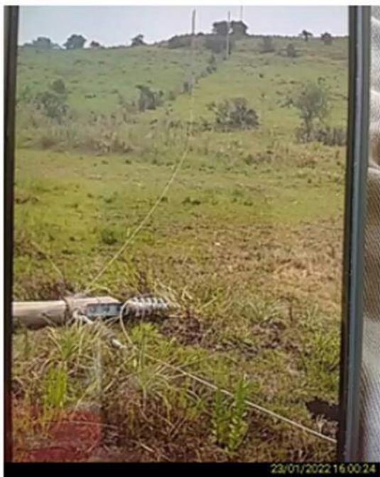
Figura 18 - Evidência de Campo. Fonte : RGE
