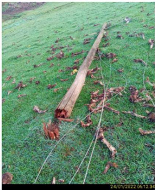
Figura 22 - Evidência de Campo. Fonte : RGE
