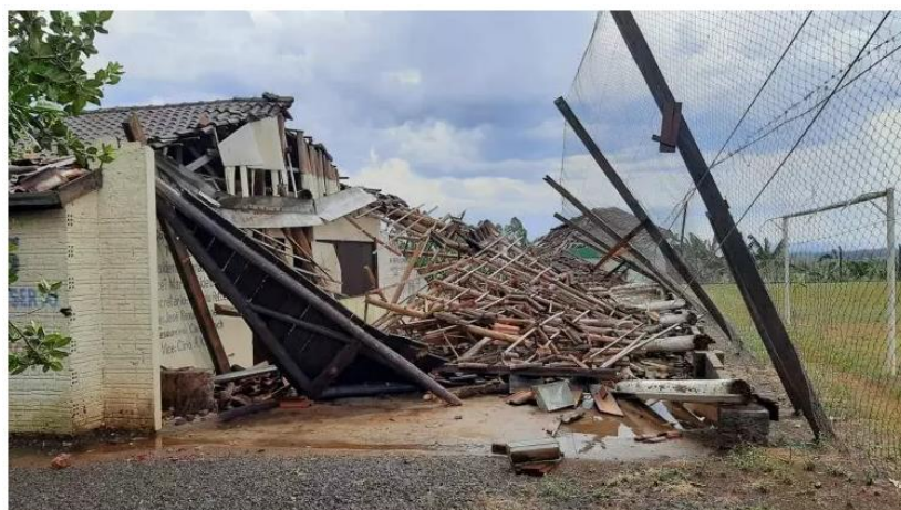
Galpão ao lado de campo de futebol caiu por causa da ventania. Foto: Divulgação / via Giro do Vale
