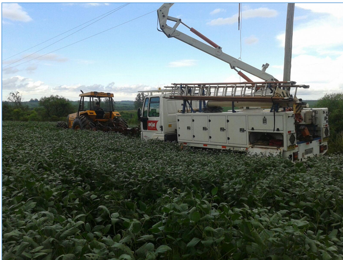
Figura 15- Exemplo evidência fotográfica – Área Santo Ângelo
