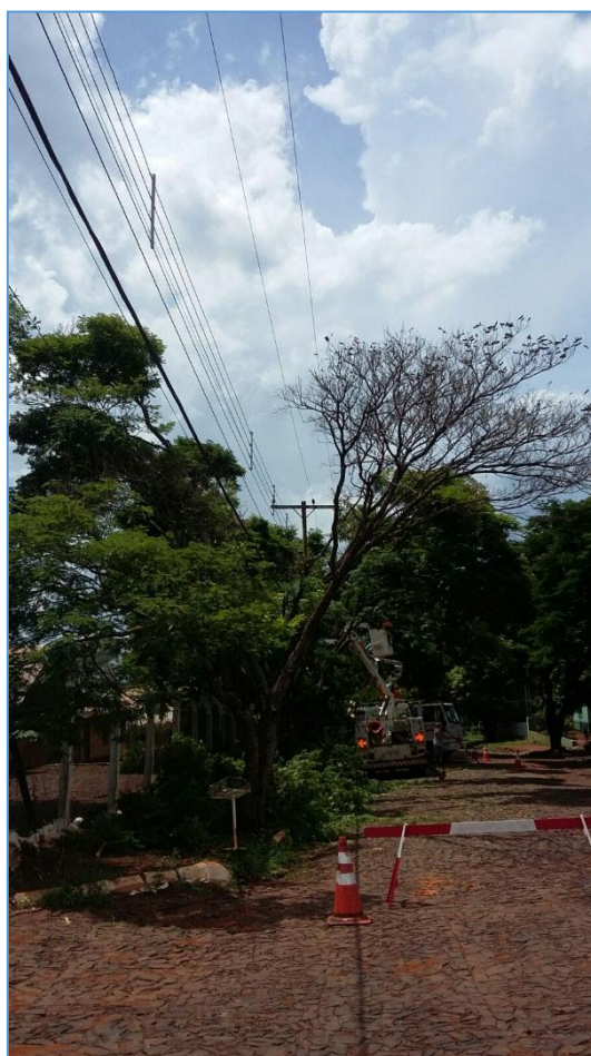
Figura 8- Exemplo evidência fotográfica – Área Santo Ângelo
