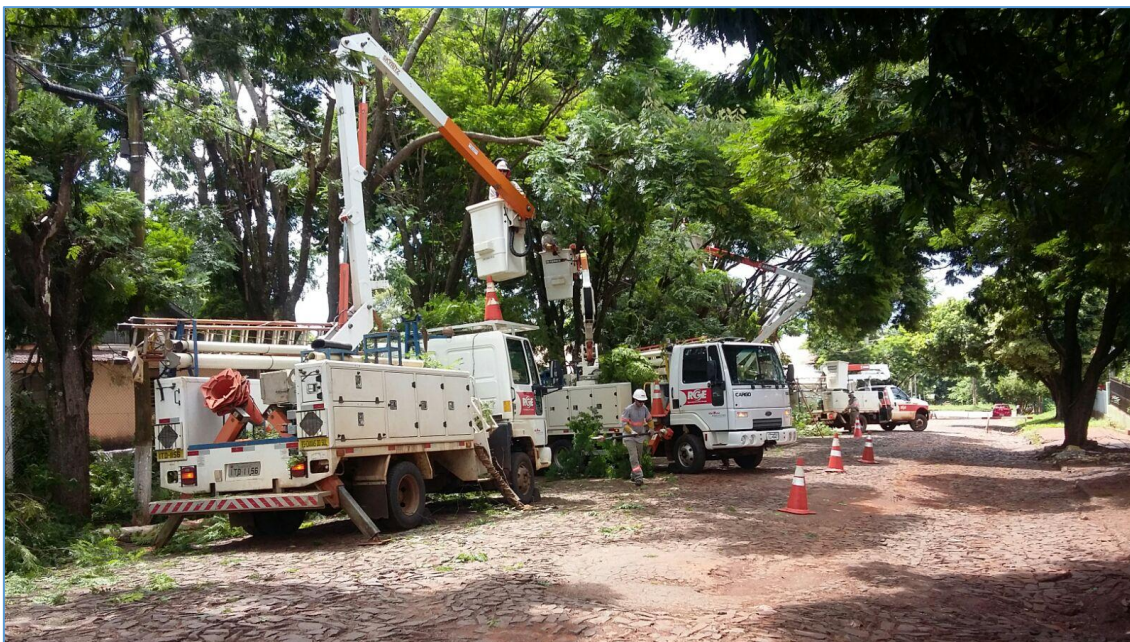
Figura 7- Exemplo evidência fotográfica – Área Santo Ângelo
