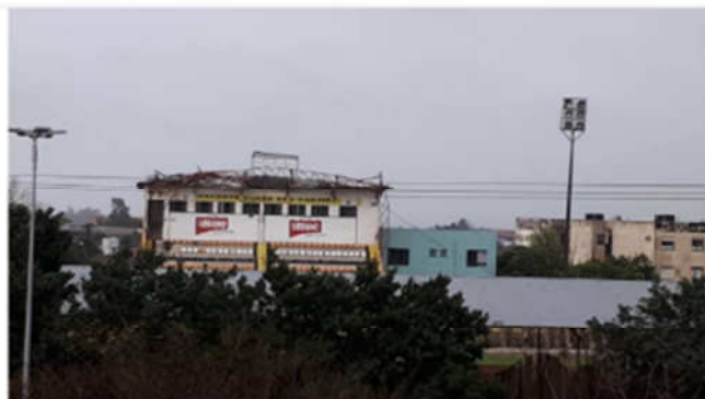
Temporal que chegou a São Gabriel nesta madrugada destruiu cobertura do pavilhão do Estádio Municipal (foto Liane Chaves)
