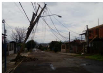
Fernanda Cristina Falkowski/Fernanda Cristina Falkowski/Especial Postes em risco de queda na Rua Ingo Lamperl, no bairro Canudos
