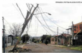
RISCO: poste na Rua Ingo Lambert, bairro Canudos
