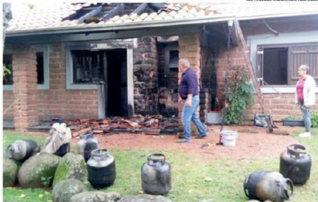
Residência em São Miguel, Cruzeiro do Sul, foi atingida por um raio. Descarga deu início a um incêndio
