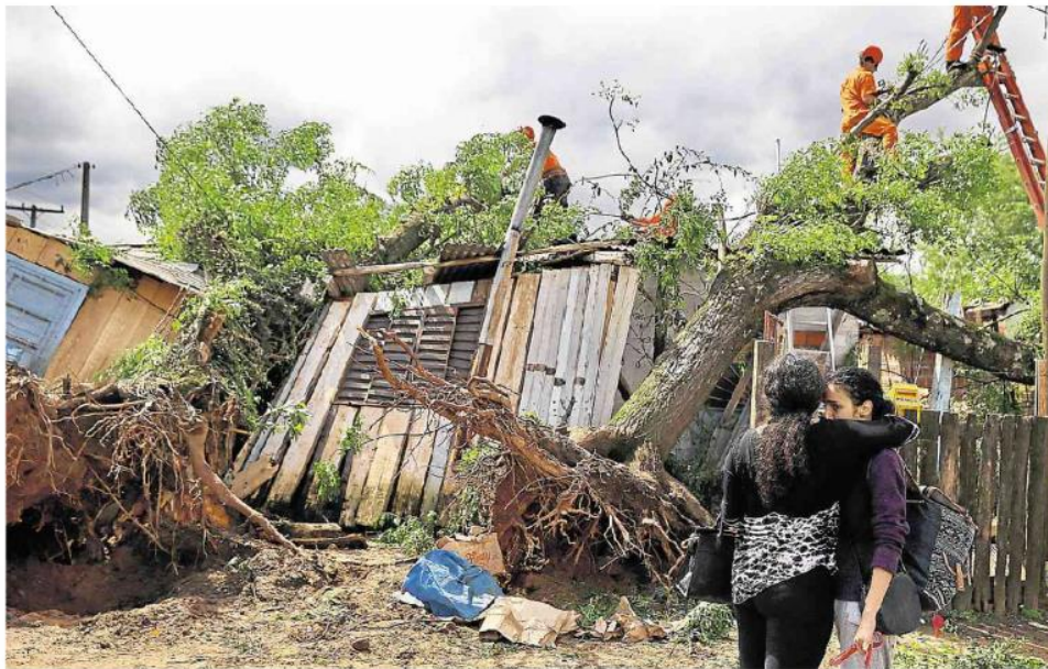
Com registro de rajadas de vento de até 133 km/h, o temporal da noite de quarta e madrugada de ontem atingiu mais de 1,7 mil casas, especialmente em Santa Maria (foto), onde pelo menos 900 residências sofreram danos. Notícias | 8 a 10 e 45
