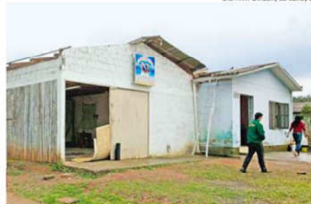
Imóveis em Sapiranga ficaram danificados com o temporal de ontem
