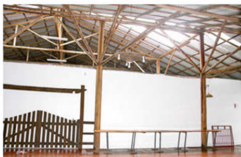
CHUVA: estrago no telhado alagou parte do CTG
