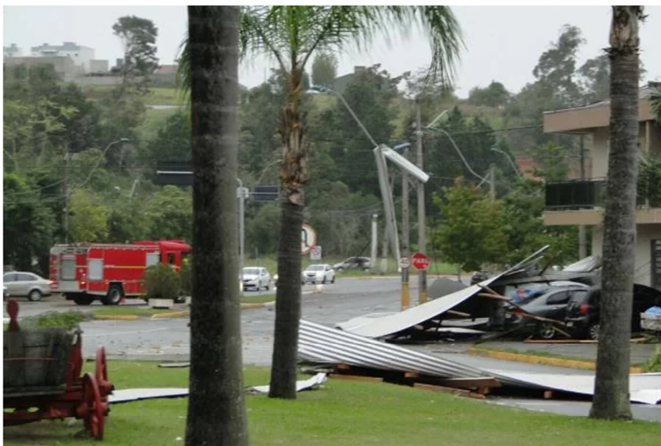
Campo Bom teve destelhamentos e danos na rede elétrica | Foto: Moraes Jr. / Play TV Channel / Especial CP
