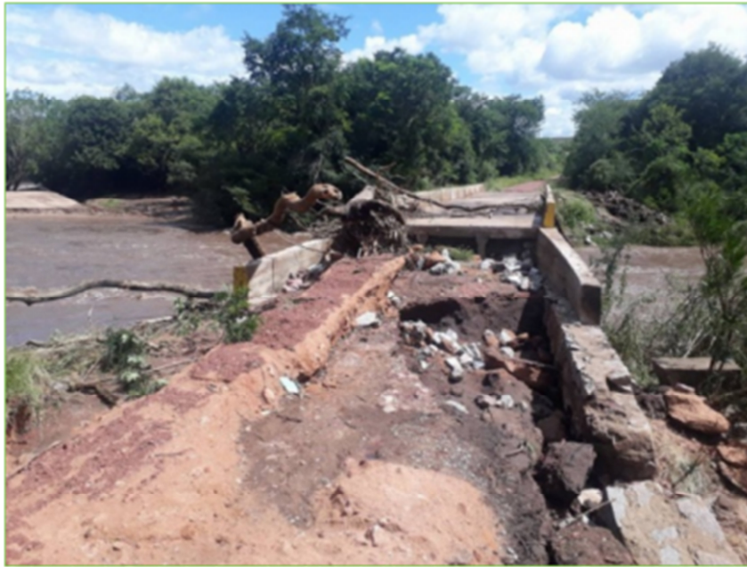
Cabeceira da Ponte dos Lanceiros foi destruída pela força da água. Foto: Rafael Teixeira
