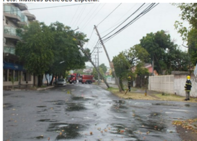
Poste caiu com o vento
