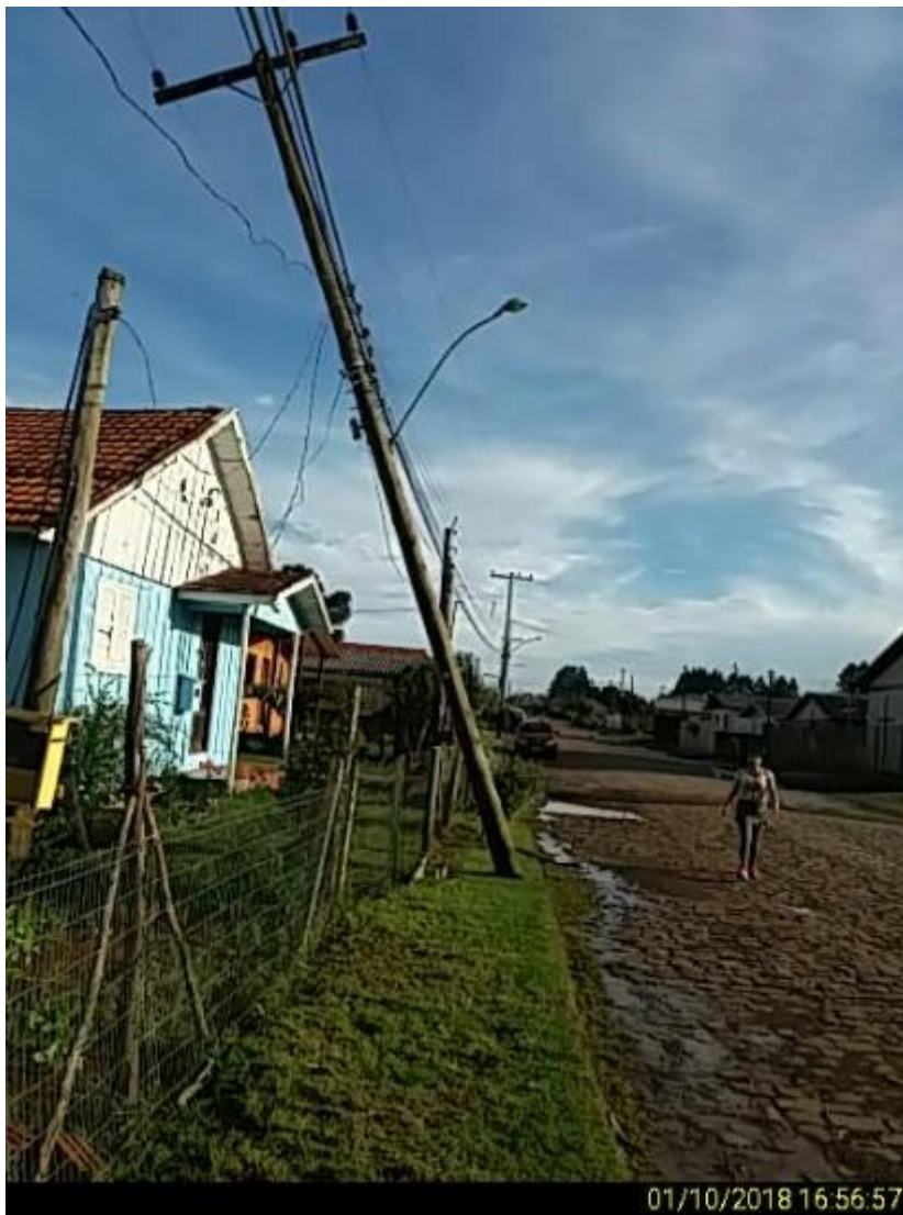
Figura 13 – Evidência fotográfica – EA Vacaria. Evento: 3001189310
