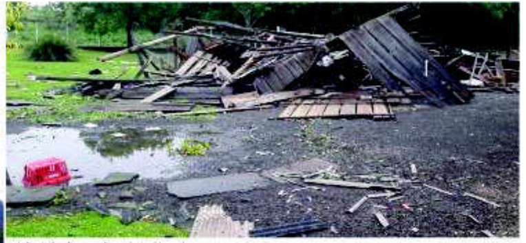
Casarão da família Ingr firma destruído após o temporal.
