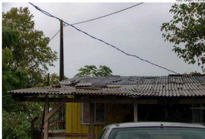
Casa com telhado danificado no Loteamento Beckenkamp
