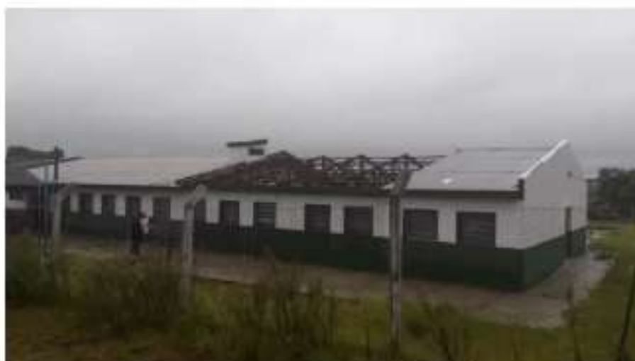
Ventos causaram danos em escola em Santana do Livramento — Foto: Lucas Bellur/RS TV
