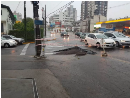
Em Santa Maria, asfalto cedeu devido a chuva em algumas ruas da cidade — Foto: Divulgação/Prefeitura de Santa Maria
