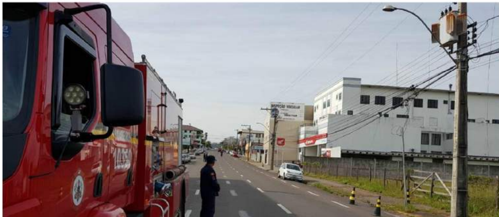
Transformador, interruptor e fios da rede elétrica entraram em curto circuito, bombeiros isolaram a quadra | Foto: Leandro Porto / Rato Gazeta
