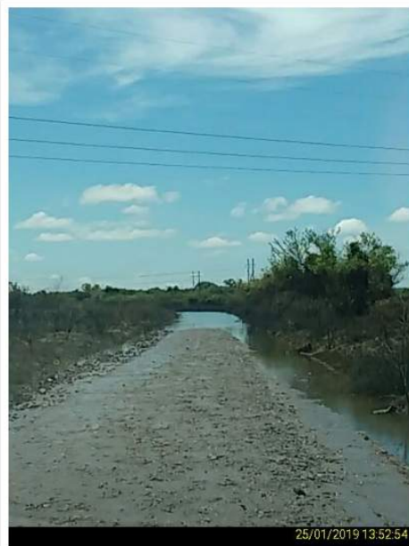
Nota/Evento: 3001491527 Data: 25/01/2019 13:52:54 Distribuidora: RGE Sul Estação Avançada: SANTIAGO
