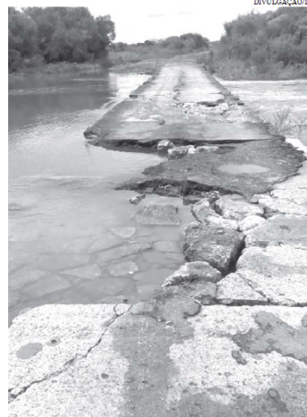
PONTILHÃO DE CONCRETO NA REGIÃO DO BOLICHO DE TÁBUA, QUE LIGA PARTE DA ZONA RURAL À BR-472. ESTÁ FICANDO ESTREITO POR CAUSA DA FORÇA DAS ENXURRADAS.
