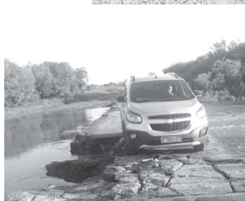
PONTILHÃO DE CONCRETO NA REGIÃO DO BOLICHO DE TÁBUA, QUE LIGA PARTE DA ZONA RURAL À BR-472. ESTÁ FICANDO ESTREITO POR CAUSA DA FORÇA DAS ENXURRADAS.
