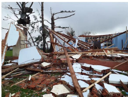
Em Ronda Alta, o salão da comunidade e uma igreja foram totalmente destruídos (Foto: Dulci Sachetti/RBS TV)
