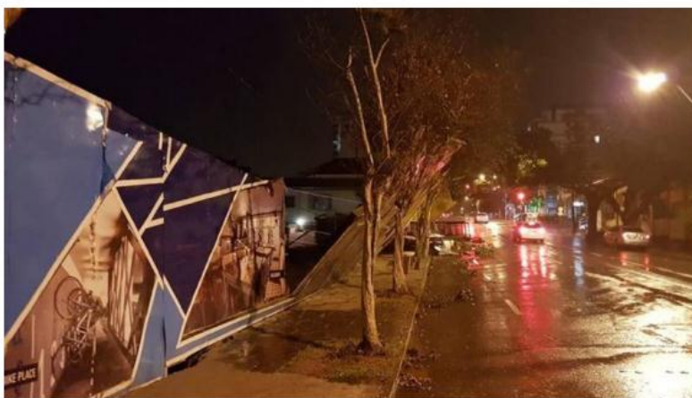
Em Caxias do Sul, a intensidade do vento foi tão forte que derrubou placas de sinalização, tapumes e destelhou residências Foto: MetSul/ Divulgação
