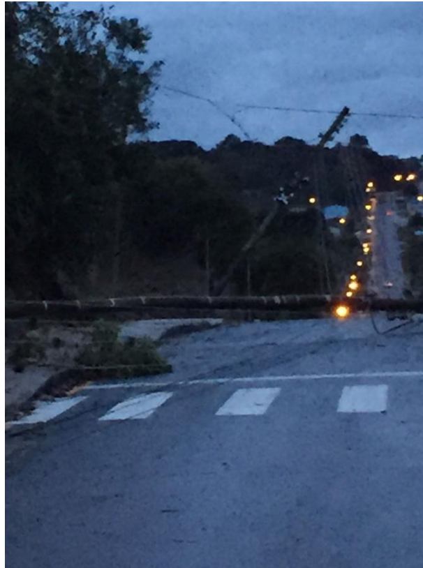
Figura 19 - Evidência Fotográfica – Região Centro – Área Urbana
